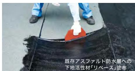
粘着工法によるかぶせ工法は機械的固定によるかぶせ工法のように下地に穴を開けないので、既存防水層を傷つけることなくそのまま活かして新規の防水層の性能がプラスされます。
